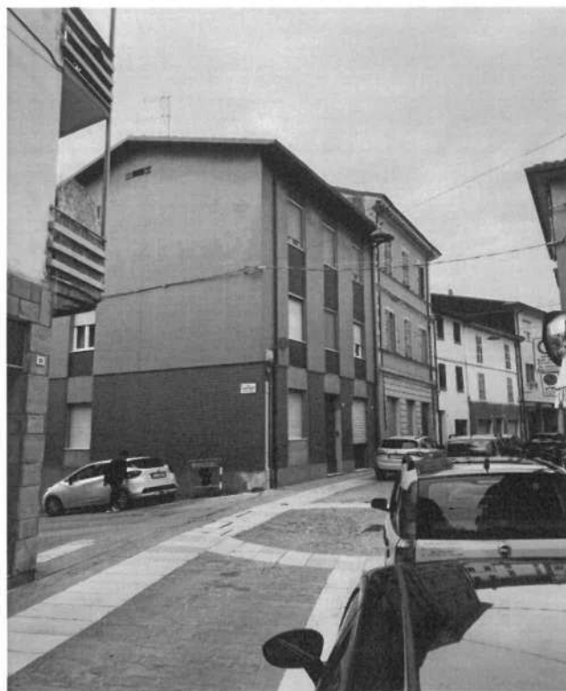
Foto 1 – Lato Fabbricato Via Matteotti ( Lato Nord )
